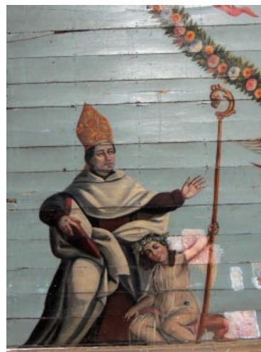
Figura 6 Detalhe da prospecção na pintura do forro da capela-mor. Igreja de Nossa Senhora do Carmo, Itu, estado de São Paulo, Brasil. Fotografia: Myriam Salomão (2013)
